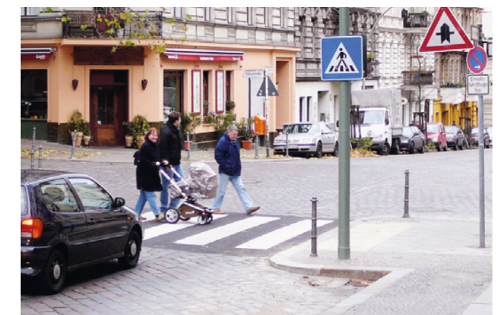
Eine Gehwegnase lässt Gehende bis vor die parkenden Fahrzeuge an die Fahrbahn herantreten und erleichtert die Sicht auf den Fahrverkehr.
